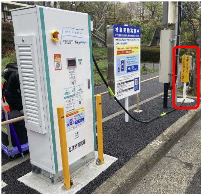
コネクタの収納場所を別に設けて、ケーブルの道路上へのはみ出しを防止
