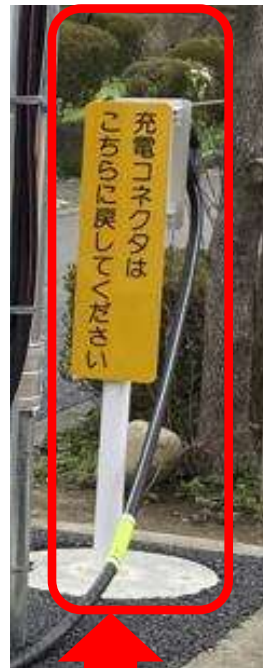
コネクタの収納場所を別に設けて、ケーブルの道路上へのはみ出しを防止
