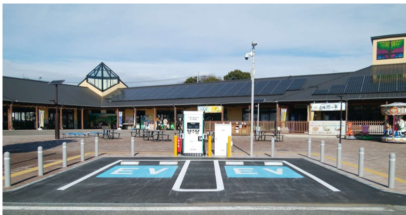
段差をなくし、十分な広さを確保したバリアフリー設計の充電設備 (北関東自動車道 壬生 PA (西行き))
